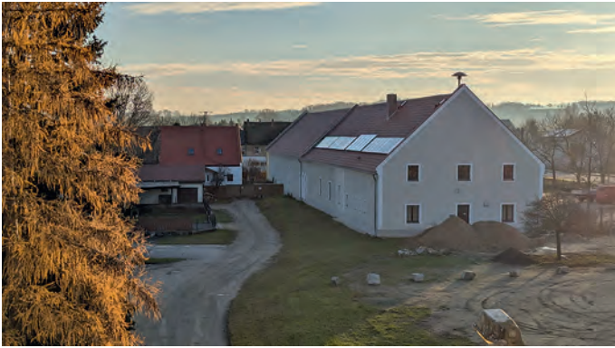
Solaranlage auf dem Bauhof Kodersdorf
